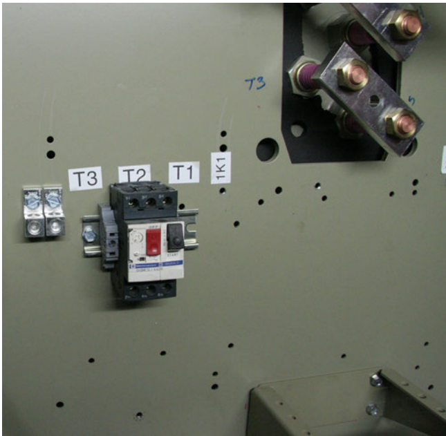
Figure 40. Din rail/1F1-1F3 fuse install
